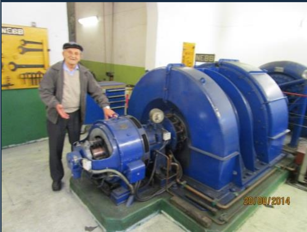
Bjarne Brekke installerte som 20-åring eit lite kraftverk i ei elv i heimkommunen Vanylven. Det gav lys til 5-6 gardsbruk. Well done, då, men no er både den og denne generatoren pensjonert, som installatøren.
