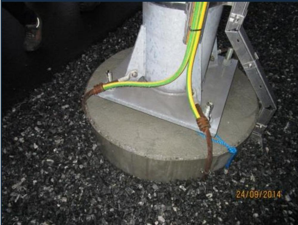
Eit omfattande system for lynavleiing høyrer med. Vi ser eit par av koparkablane som skal leie eventuelle lyn-nedslag utanom sårbare installasjonar, ned til eit omfattande nett av koparkablar under overflata.
